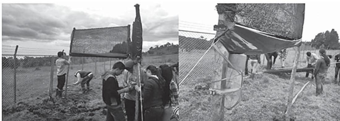
Figura 2. Colectores de captación de neblina. Detalle de canaleta, filtro y tensor.
